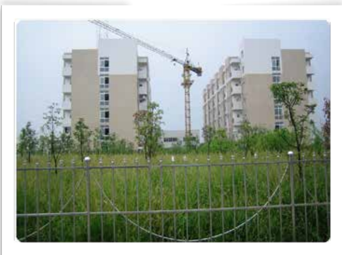
正在建的新宿舍
